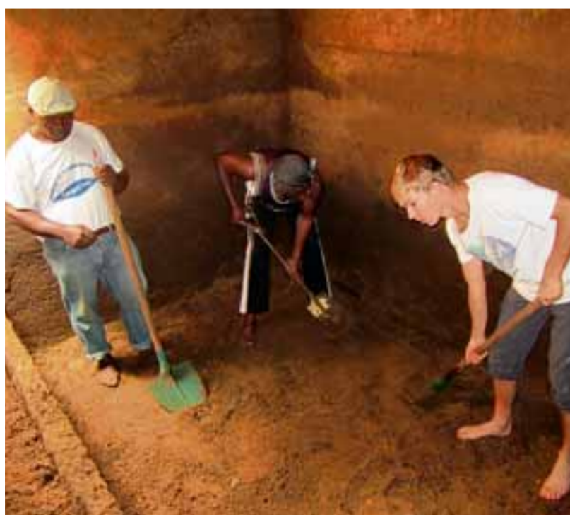
Einheimische und Mitarbeiter der Humanitären Hilfe (rechts Praktikant Andreas Leitmeier) beim Ersetzen des Sandes in der Wasserfilteranlage.
