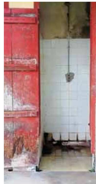
Vor der Sanierung: So fanden die deutschen Ärzte die Klinikduschen vor.
