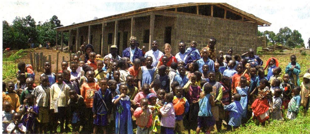
Das Gebäude steht, im kommenden Jahr soll der Bau dann fertiggestellt werden. Fotos (2): privat
